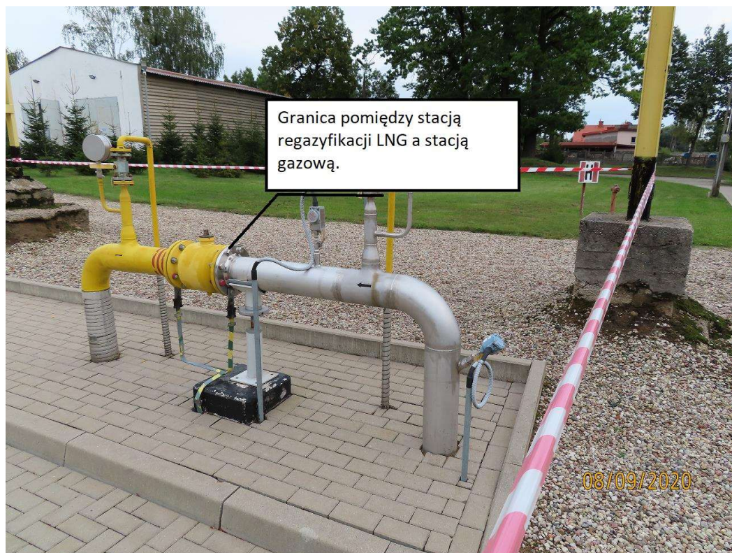
Rys. 2 Granica pomiędzy stacją LNG a stacją gazową.
